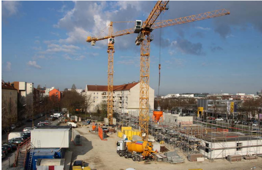
Eine Baustelle am Frankfurter Ring in München
